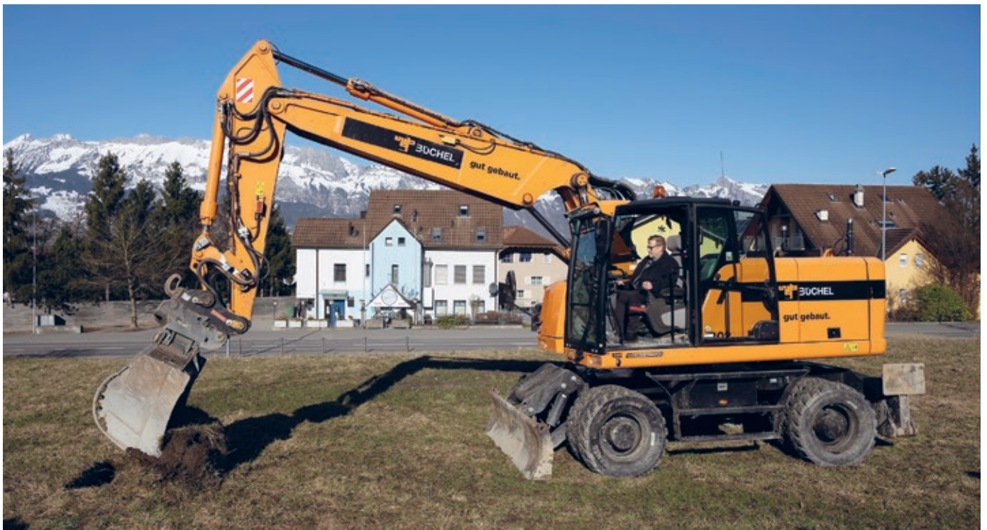
Baustart der neuen Protekta am 10.02.2022
