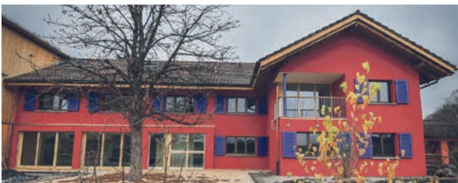
Hausansicht von der Rietstrasse
