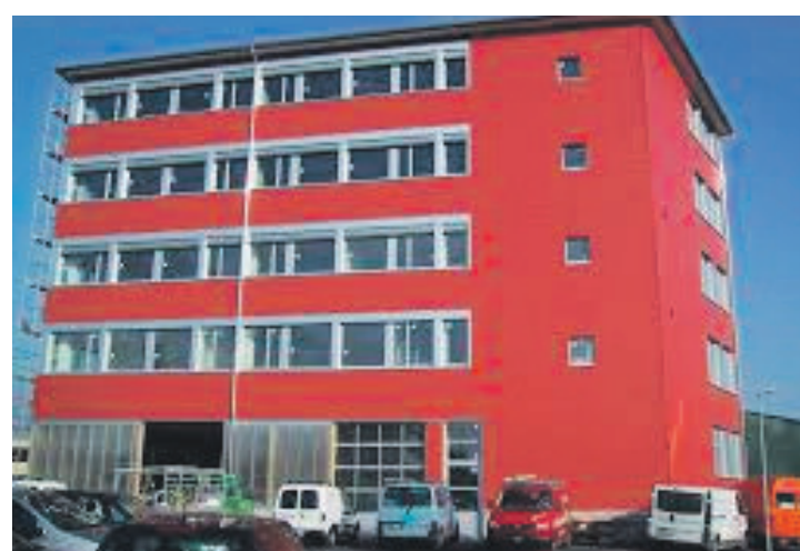
Die Auxilia befindet sich im alten Riet in Schaan.
