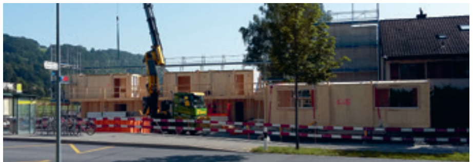
Am 19.06.2019 wurden die ersten drei Holzelemente angeliefert und auf dem Areal platziert
