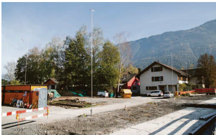
Voller Vorfreude zeigt Rebecca Marxer, Bereichsleiterin Wohnen im HPZ, wie das neue «Birkahus» aussehen soll. Voraussichtlich im Dezember ist der Spatenstich, nach rund einem Jahr Bauzeit dürfen die 13 Bewohner dann in ihr neues Zuhause einziehen. Bild: Daniel Schwendener
