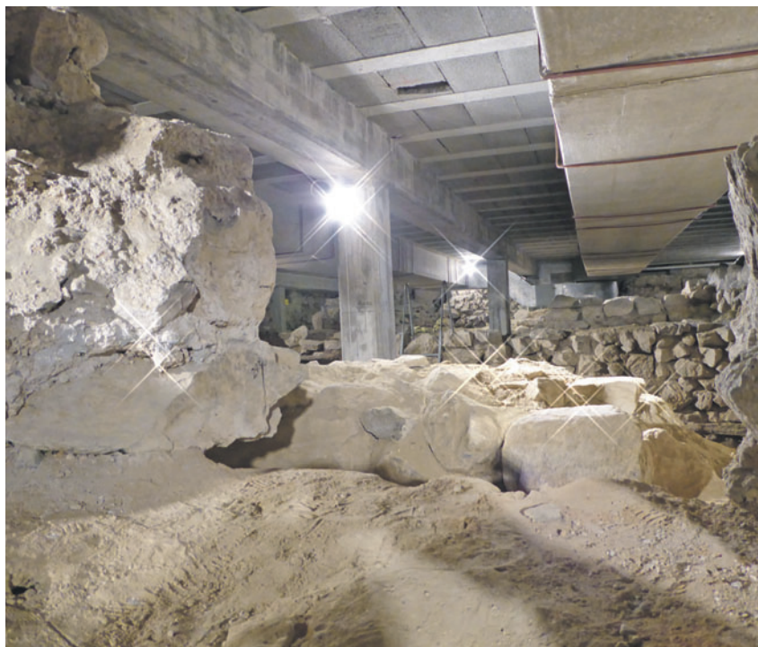
Blick auf Grundmauern früherer Bauten. Sie sind unter der heutigen Pfarrkirche immer noch erlebbar. (Foto: ZVG)
